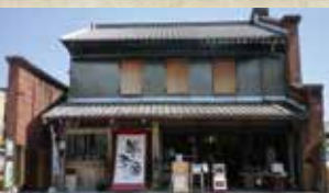
東側の煉瓦は、2階建ての外観にあわせたユニークな形をしています。 問・休)SNSをご確認ください
